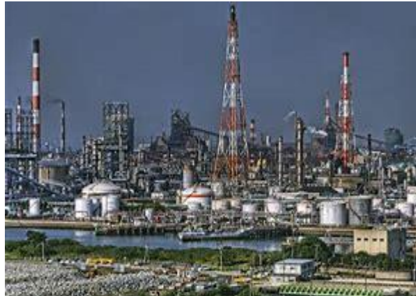
【石油プラント】
